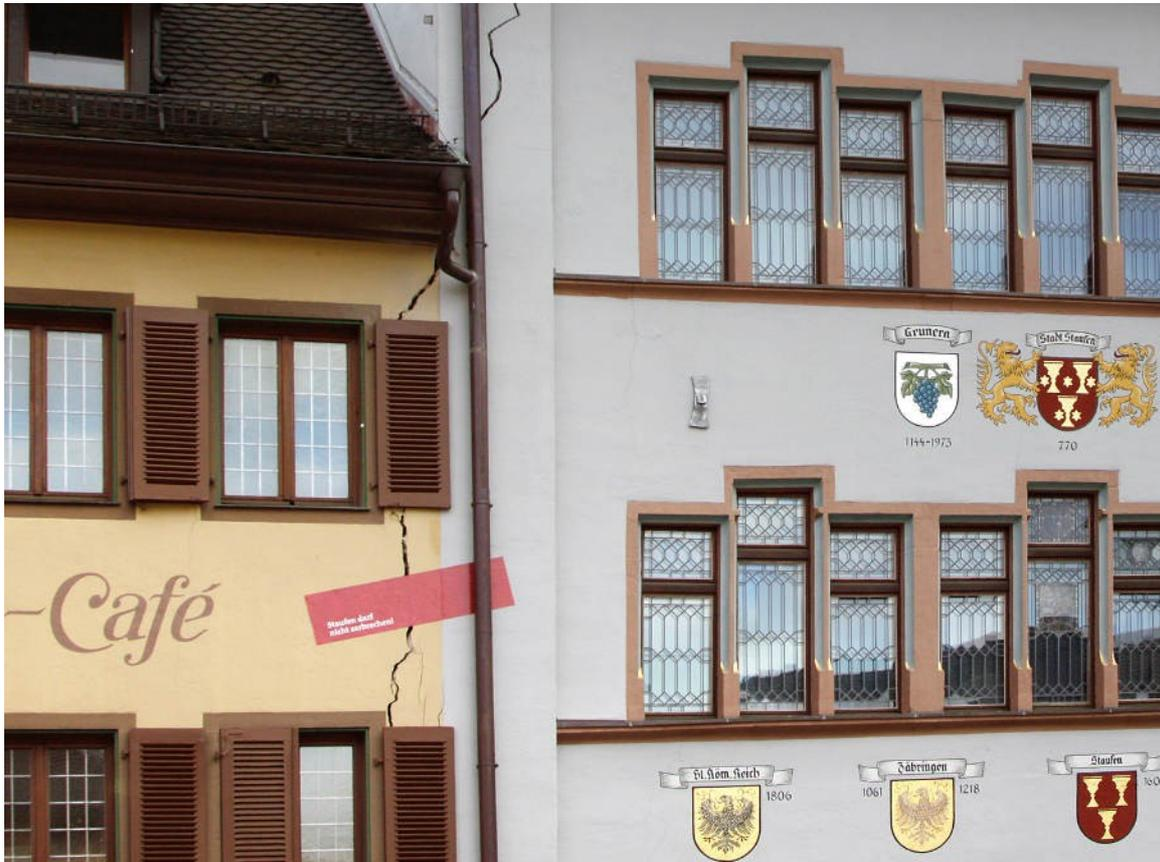
*Über weite Strecken sollen unter Stuttgart Tunnelröhren durch quellfähigen Gipskeuper gebohrt werden - das gleiche Gestein, das bei Wasserkontakt mit physikalischer Urgewalt die Altstadt von Stauffen im Breisgau hebt und sukzessive zerstört.*
